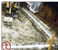
2 Pose de la semelle filante à l'emplacement de la cave.
