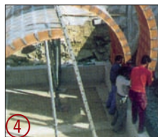
4 Grutage et assistance pour le montage des différents éléments (généralement en moins de 4 heures).
