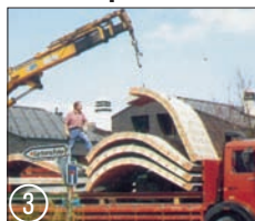
3 Livraison des modules voûtés préfabriqués par camion grue.
